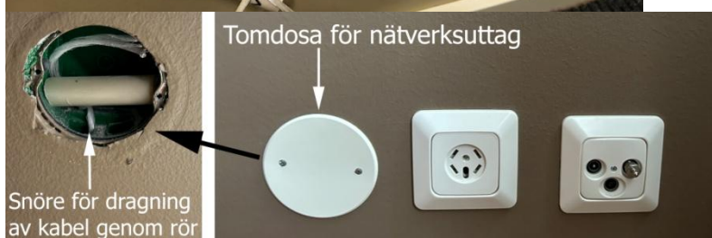
Tomdosa för installation av nätverksuttag.
